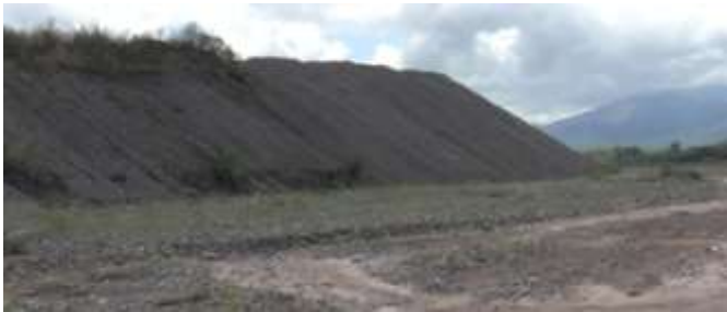
Defensas artificiales con descarte de áridos en Vallenar 2 (río Toro, 2009)
